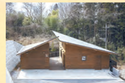
野鳥の森管理棟・トイレ
