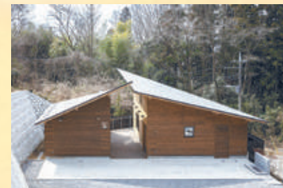
野鳥の森管理棟・トイレ
