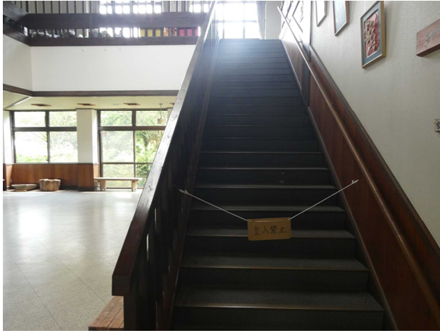
〈18内観：エントランスホール階段〉
