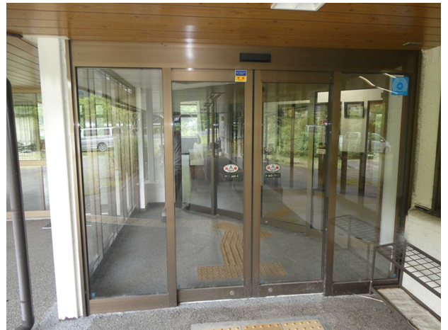
〈⑪外観：正面入口〉
