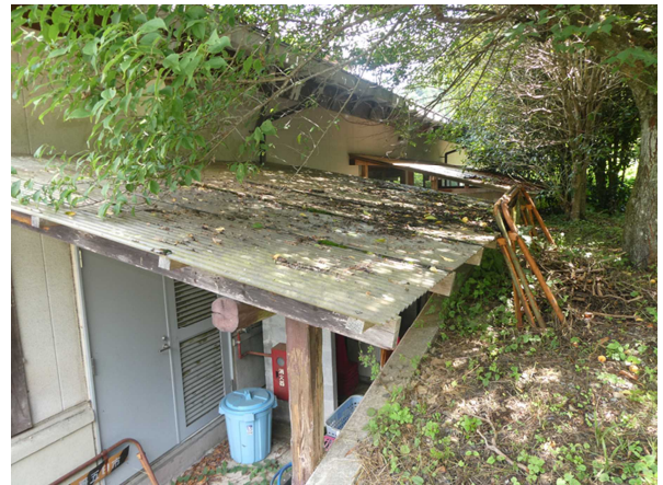
〈④外観：西側（研修室（陶芸の家）、窯場）〉
