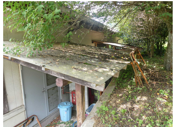
〈④外観：西側（研修室（陶芸の家）、窯場）〉
