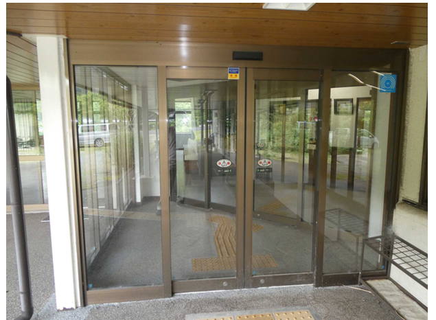
〈⑪外観：正面入口〉
