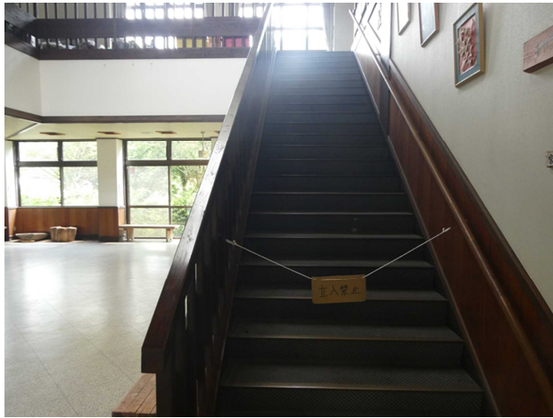
〈⑮内観：エントランスホール階段〉
