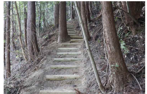
整備を行った散策路(寺岡階段)
