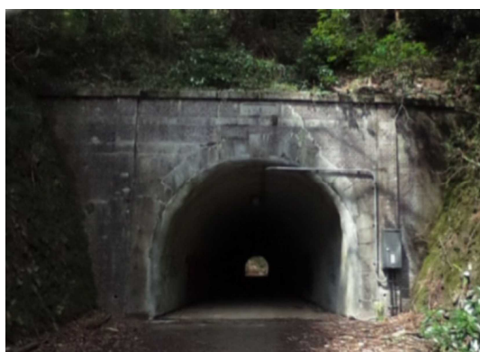
写真-1 旧小峰トンネル
