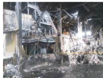
処理施設での火災の様子
