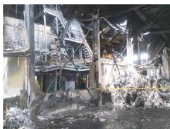
処理施設での火災の様子
