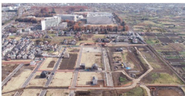
武蔵引田駅北口区画整理地内
