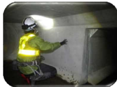
打音点検状況
