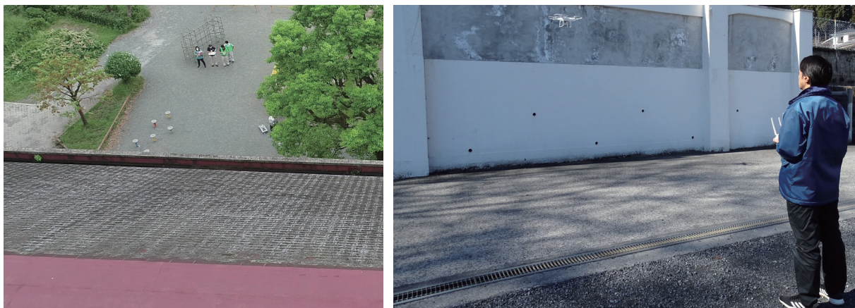
ドローンを活用した建物点検
