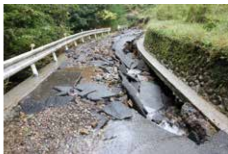
令和元年(2019年)の台風第19号 による被害(宝沢林道崩落)
