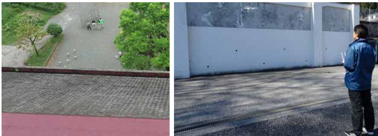
ドローンを活用した建物点検
