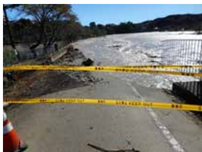
令和元年(2019年)の台風第19号 による被害(山田の堤防決壊)
