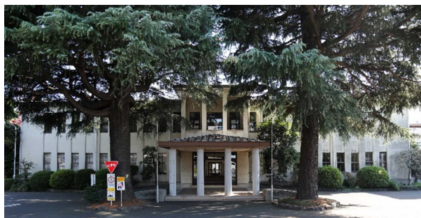
日本無線株式会社三鷹製作所 101号棟
