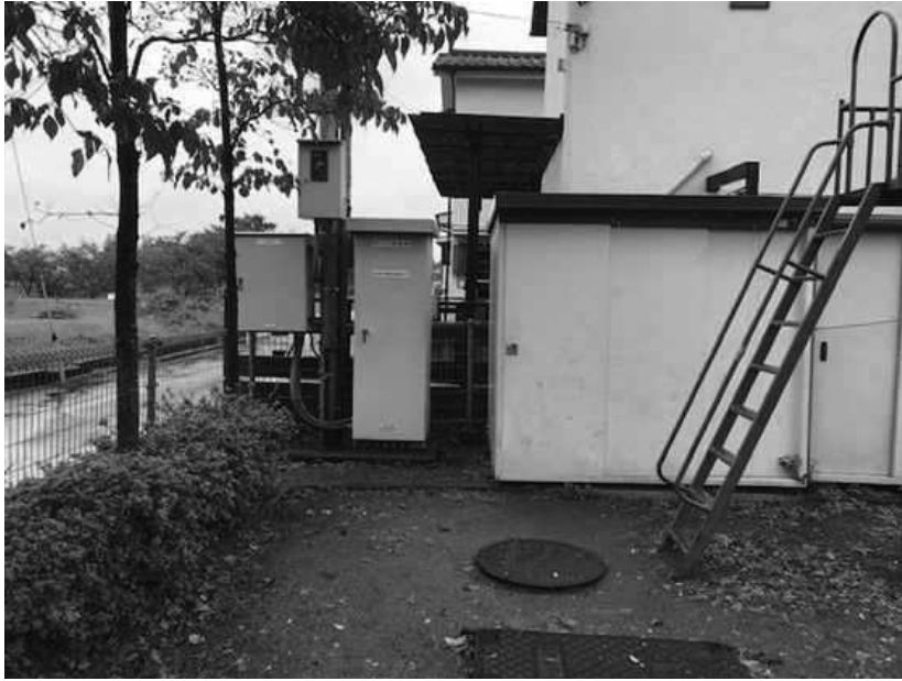
7番 永田橋西公園ポンプ ポンプ場全景
