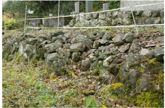
↑ かつてのシシ垣らしく石垣の上が道になっている様子です。
