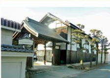
日本一の養蚕農家の面影が残る桑保管倉庫。他では見られない半地下式の倉庫で、周囲外壁も当時の面影が残る。
