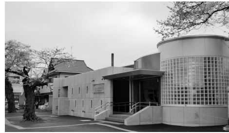
新しくなった武蔵増戸駅(平成23年3月)
