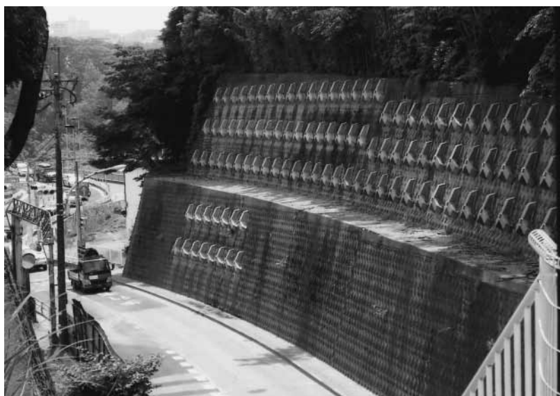
ロックボルト工法で補強された擁壁
