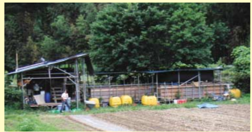
バイオガスプラント
