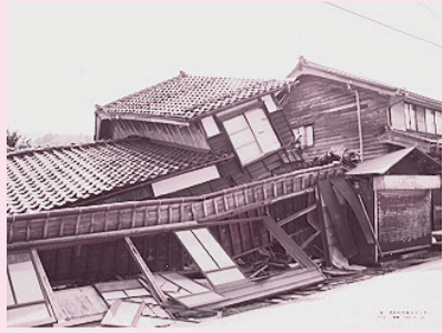
写真提供: (一財)消防防災科学センター「災害写真データベース」
