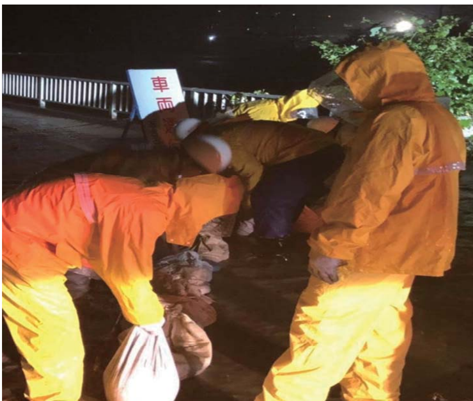
土のう積み作業
