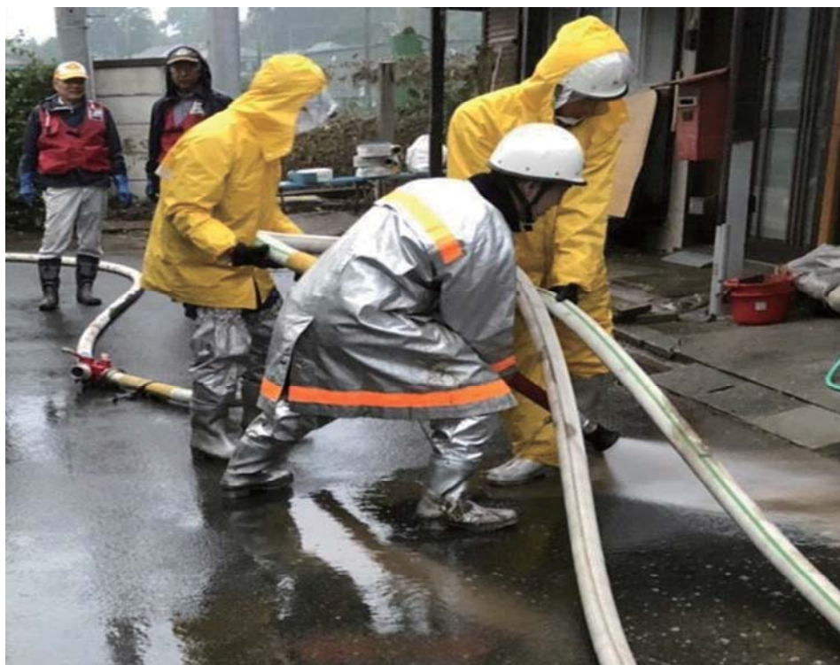
堆積土砂撤去作業
