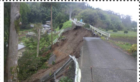
▲市道戸倉119号線道路災害復旧事業
