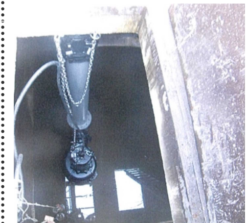
▲留原中村地区排水ポンプ整備事業
