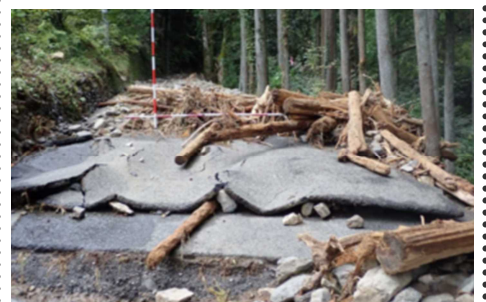
▲林道大沢線災害復旧事業
