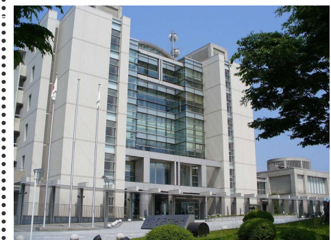
▲庁舎空調設備改修事業
