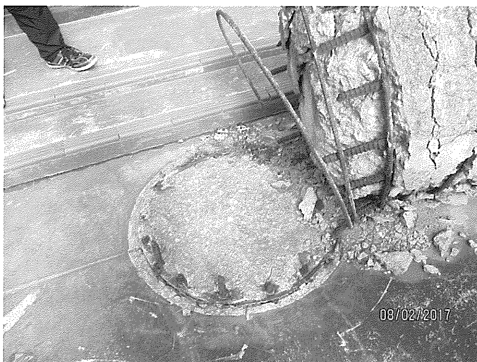
前述の円柱の切断面コンクリートが内部によく充填されており表面の打ち放しコンクリートもきれいに仕上がっていた。
