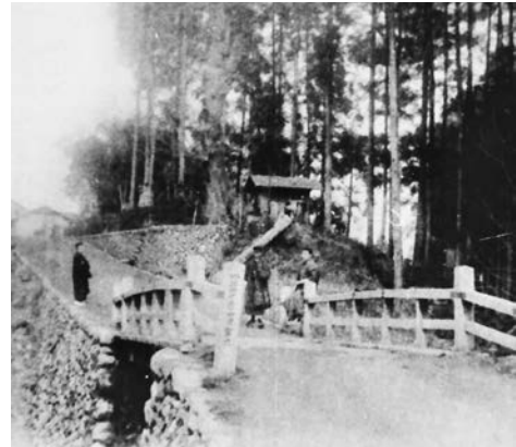
改修工事の終わった西沢橋と番場坂 五日市警察署前の都道はまだなかった [明治40年4月]
