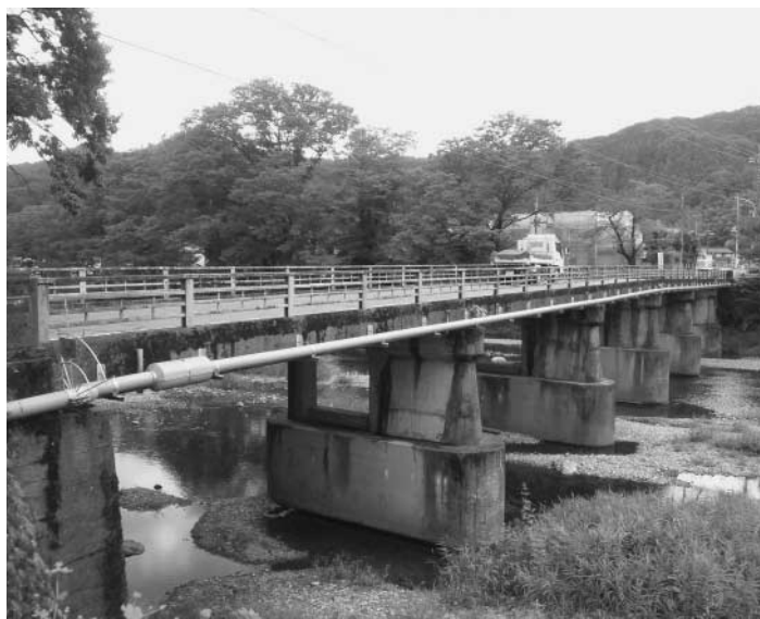
建設から46年が経つ小和田橋
