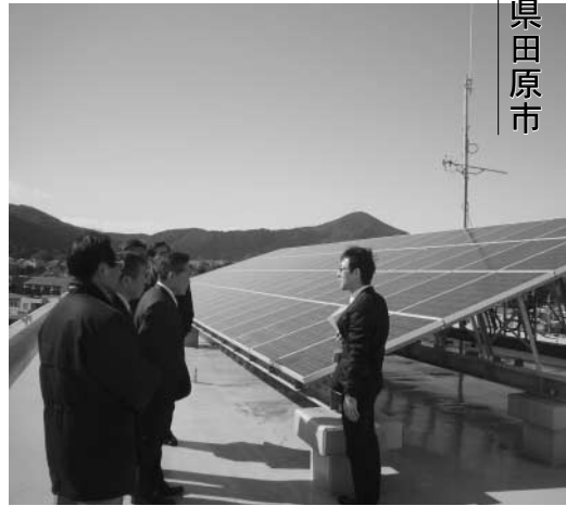
田原市庁舎屋上に設置された太陽光発電
