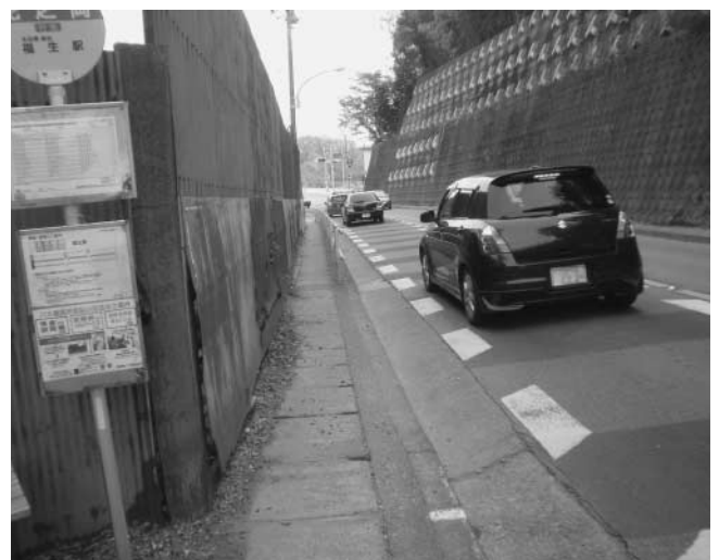
歩道の狭い永田橋周辺
