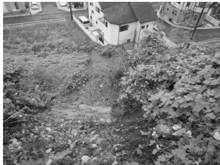
がけ崩れのあったブリティッシュタウン
