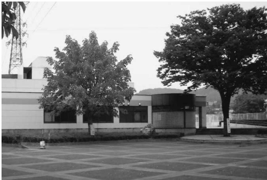
屋外と屋内のプールがある草花の市民プール
