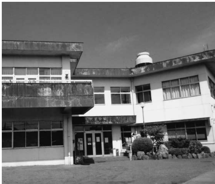
老朽化が進む千代里会館
