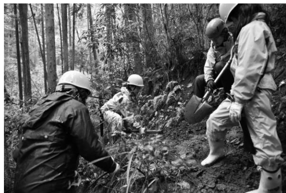
＜コレンジャーによる道の補修作業の様子＞
