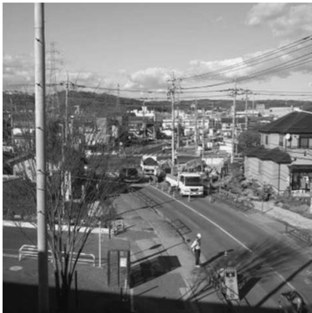
拡幅工事が進む市内の道路
