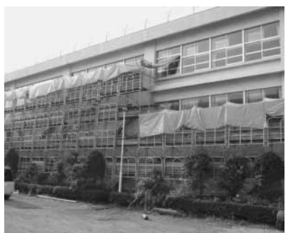
耐震化工事が進む秋多中学校
