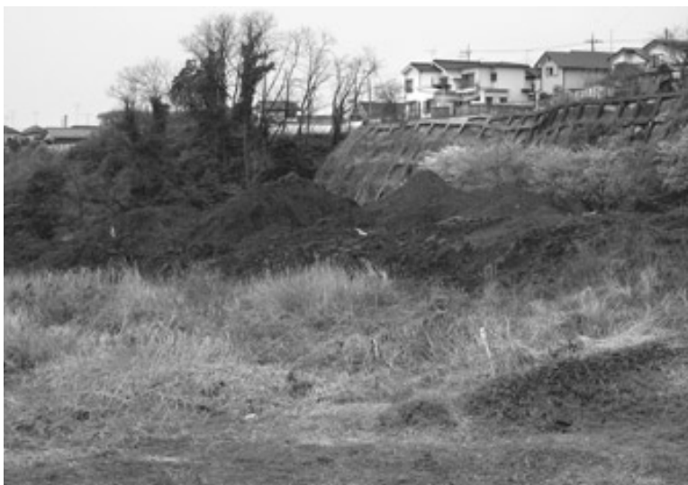
多摩川永田橋下流右岸の汚泥
