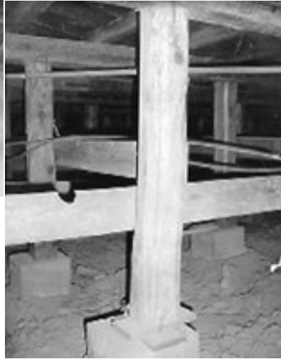
屋城小学校体育館の床下
