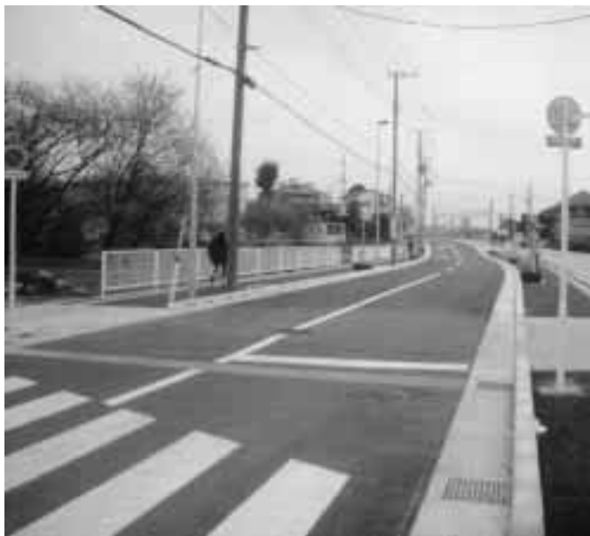
武蔵増戸駅前13m道路
